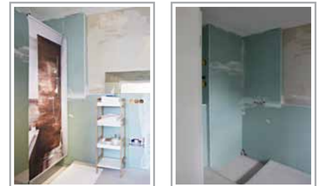
Sogar im Rohbau kann ein professioneller Home Stager mehr Raumgefühl vermitteln.
